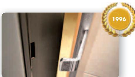
Brevetto Rostro a piastra per breve lasco tra telaio e rostro, che diminuisce lo spessore tra la porta ed il telaio.
